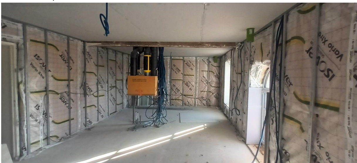
Isolation murale : 19 cm de laine de bois et membrane
