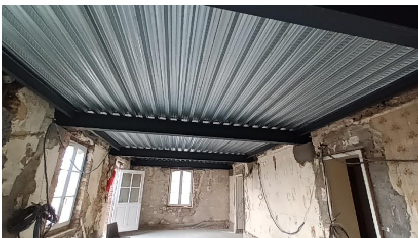
Plafond en bac acier avec poutrelles en fer
