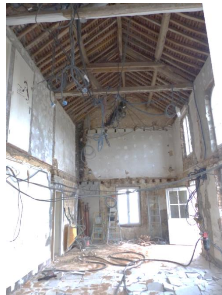
Démolition des planchers intermédiaires
