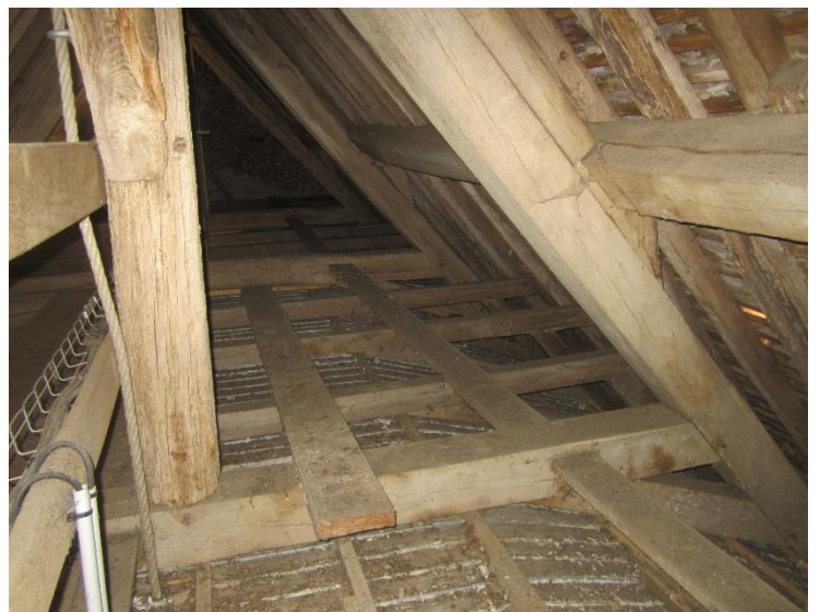
Le chemin d'accès à la cloche dans le clocher parfaitement entretenu
